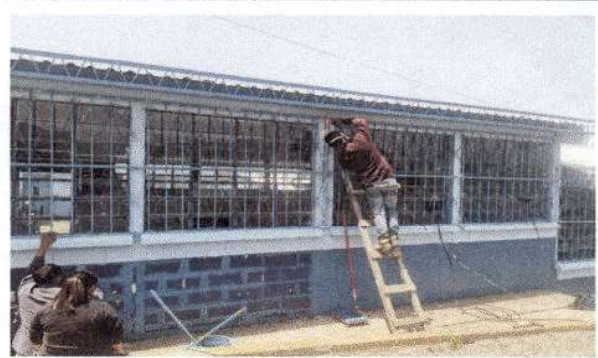
Foto 2. Mantenimiento a balcones
