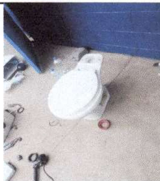
Foto 10. Sustitución de inodoro
