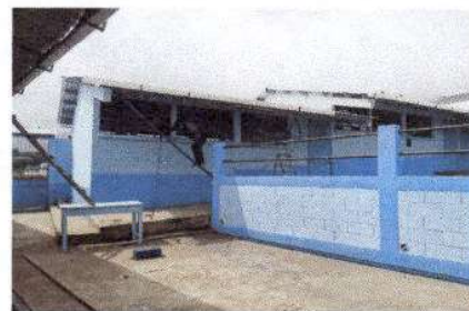
Foto 6. Sustitución de vidrios
