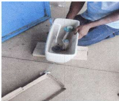
Foto 3. Sustitución de accesorios de sanitarios
