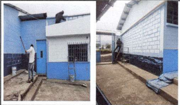
Foto 4. Pintura de muros exteriores e interiores
