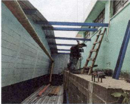
Foto 1. Sustitución de lámina, sustitución de soporte de madera.
